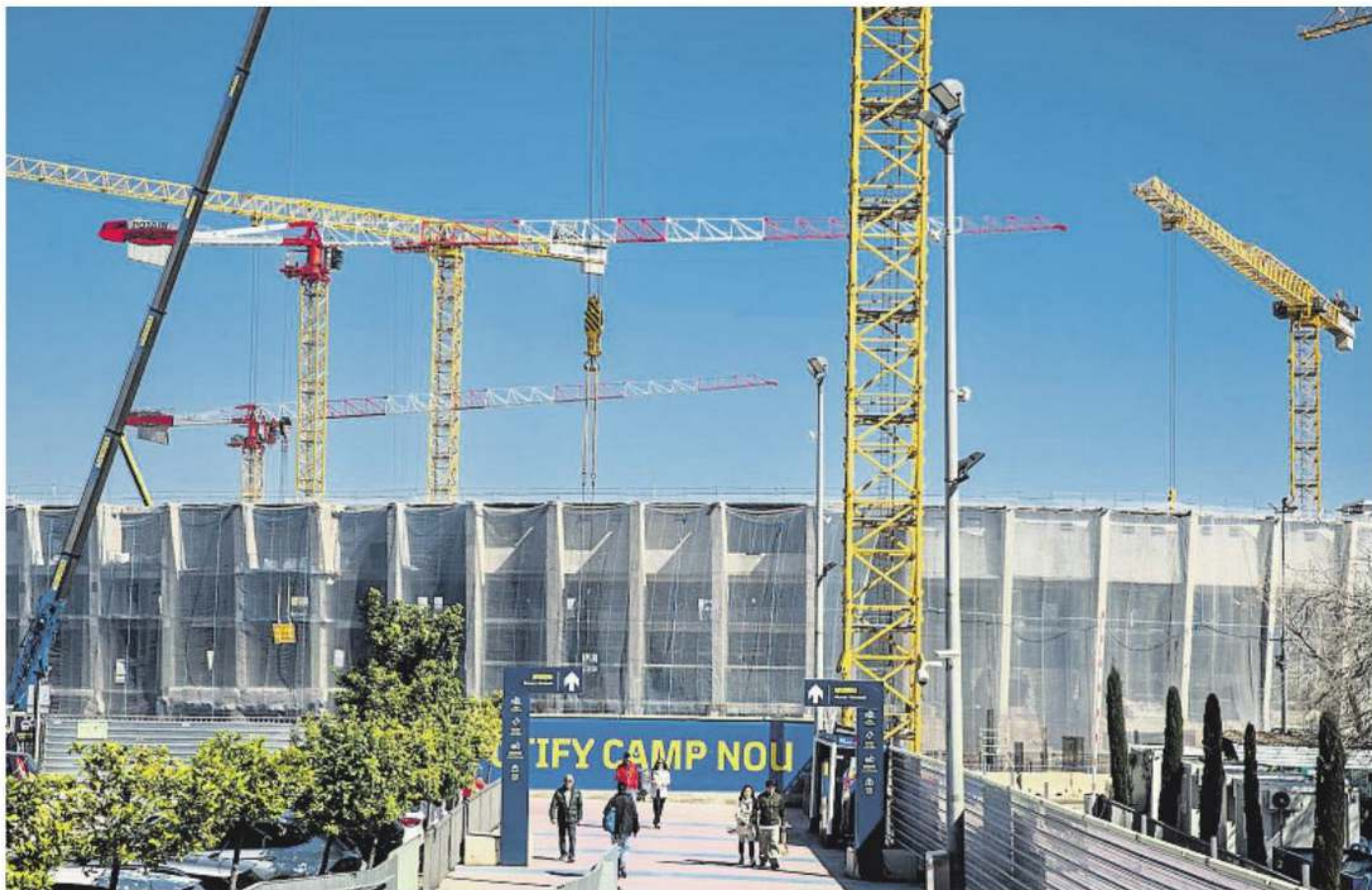
Las obras del Spotify Camp Nou van avanzando con 1.400 operarios de la constructora Limak trabajando en su interior
